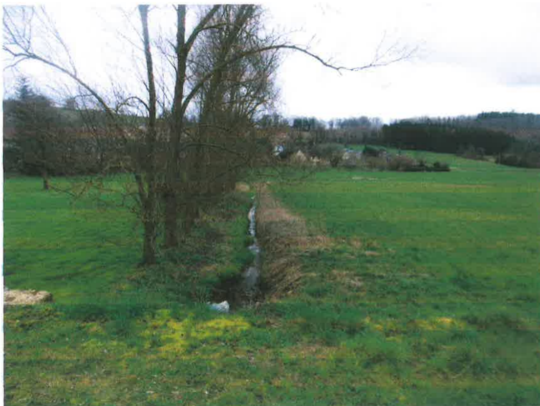
Un des fossés de recueil des eaux (pré-) traitées
