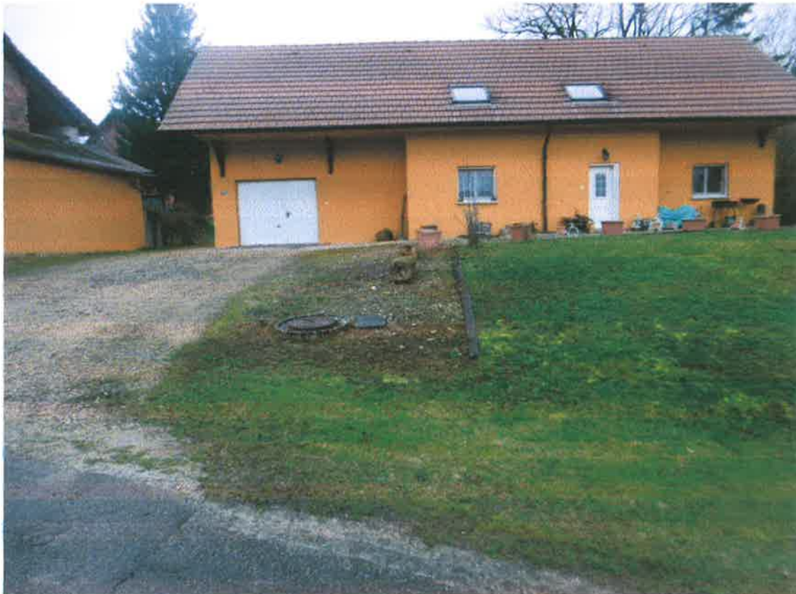
Installation devant maison individuelle, les effluents sont recueillis dans la canalisation des eaux de pluie
