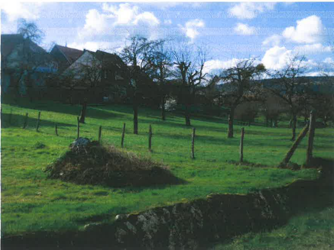
Caniveau d'écoulement de l'III, recueillant les eaux traitées des habitations en haut à gauche
