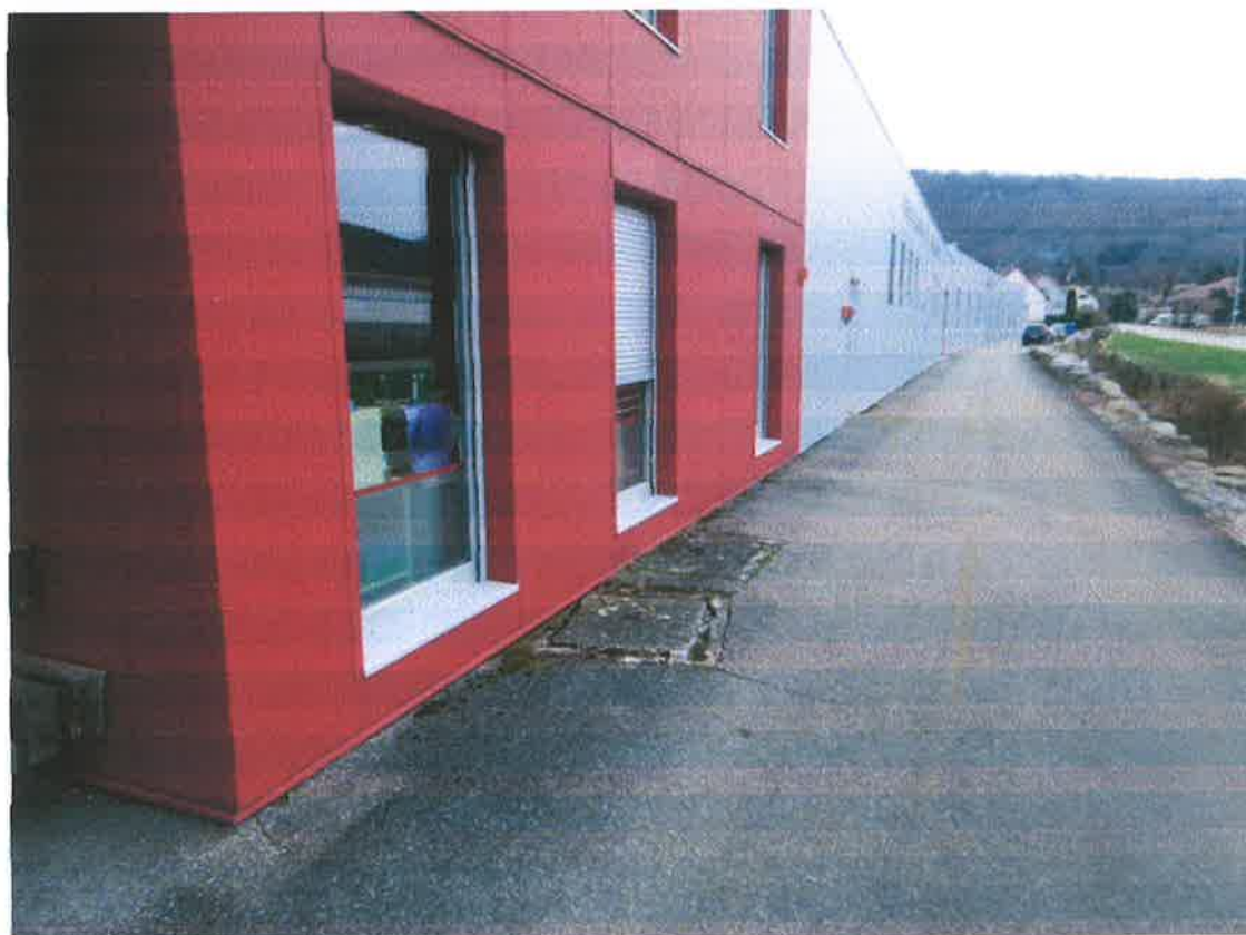
Fosse septique des Ets Griesser
