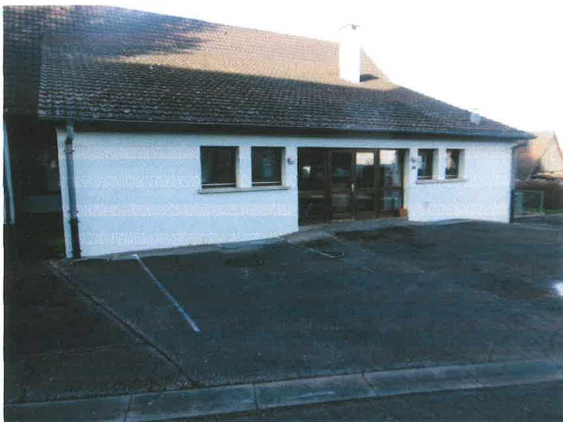
Fosse septique devant la salle communale
