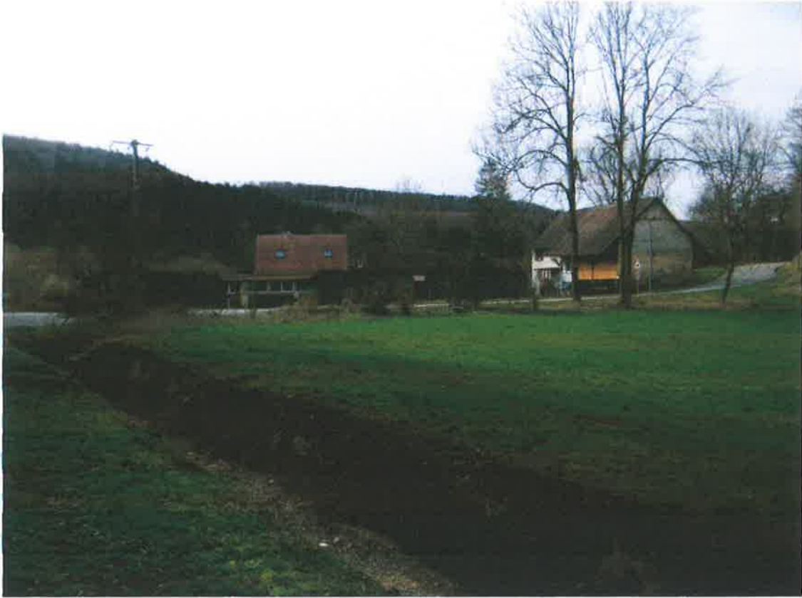
La Vieille Scierie en bordure de l'III et le fossé descendant du village, émissaire des eaux usées traitées
