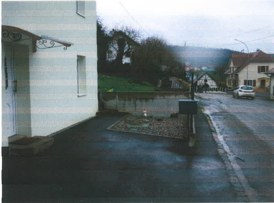
Une habitation récente équipée d'une microstation
