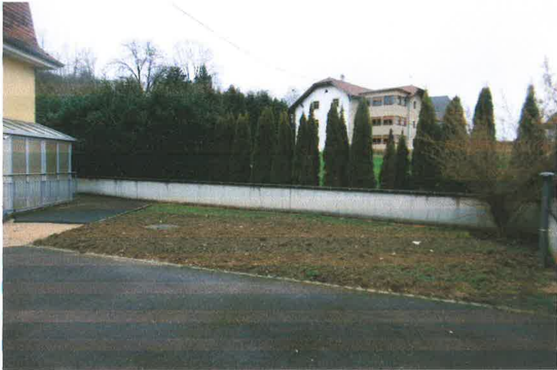
Fosse toutes eaux et lit de filtration derrière la mairie
